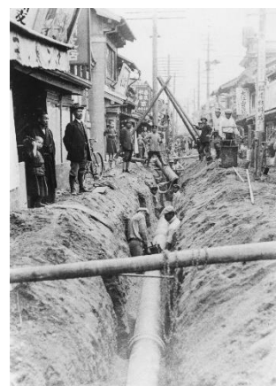
④ 博多部の配水管布設
